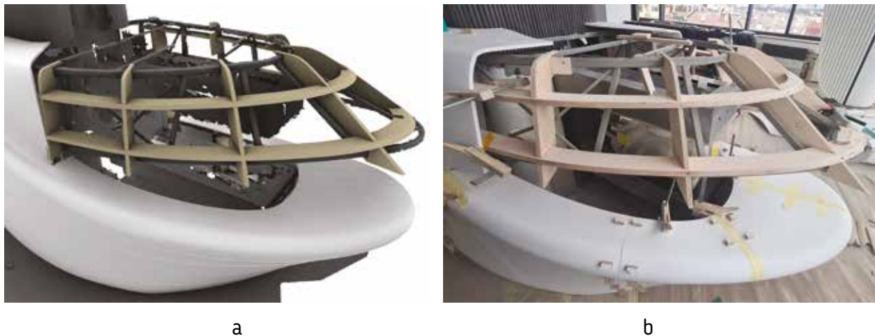
Ил. 11 а, б Носеща конструкция, монтажна конструкция и облицовъчни панели; а) дигитален триизмерен модел; б) снимка от реално изпълнение. © Р. Шишков, 2023
