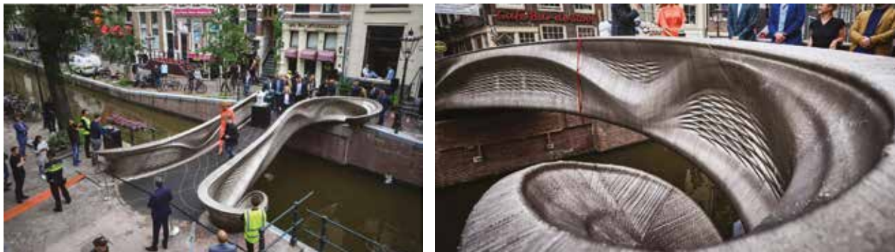
Ил. 2 а, в. Първият 3D принтиран метален мост в Амстердам
