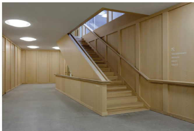
Ил. 1. Шлайфан бетон в комуникациите
