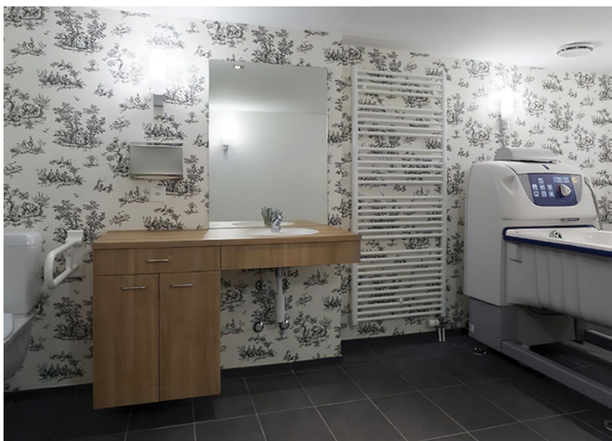
Ил. 18. Водоустойчиви тапети в специална баня
